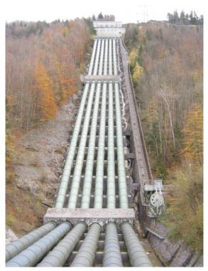
Das 1924 fertiagestellte Speicherkraftwerk den nutzt Höhenunterschied zwischen einem hoch gelegenen Speichersee (dem Walchensee) und dem tiefer Wasserkraftwerk aeleaenen (am Kochelsee). Über die sechs 400 Meter
